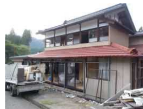
交流拠点の改修(湯沢市)
