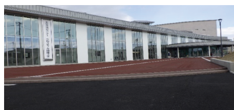
JV利府町文化交流センター「リフノス」建設工事
