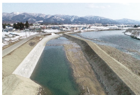
県単河川改良工事(緊急自然災害防止債)
