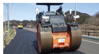
国道 舗装工事
