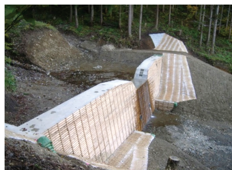
谷内地区 復旧治山工事
