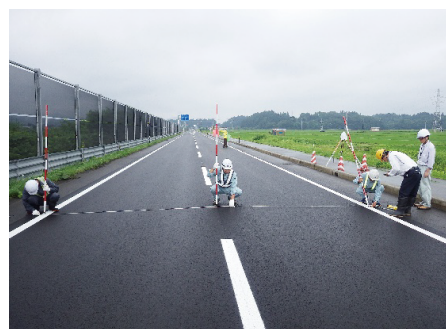
地方道路交付金工事
