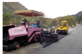
白沢地区道路改良工事
