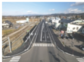
横手地区歩道工事
