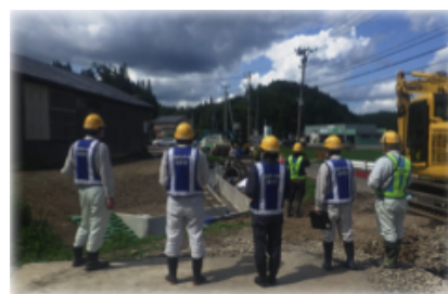
現場パトロールの様子
