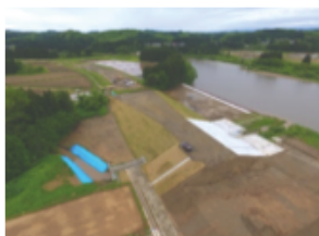
雄物川上流強首・寺館地区 築堤護岸工事
