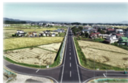
県道大曲大森羽後線工事
