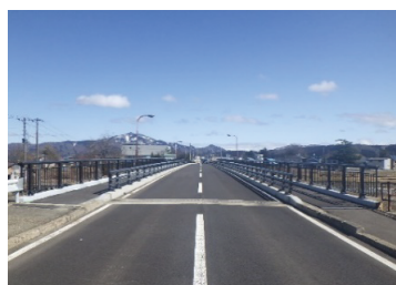
湯沢地区構造物補修工事 (東北地方整備局長表彰受賞)
