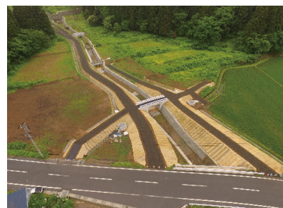
火山砂防工事
