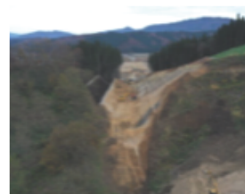
小白岩地区道路改良工事
