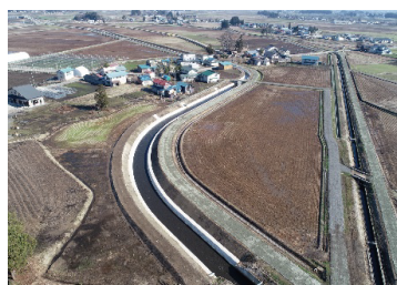
農業水路整備工事
