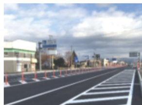
横手十字地区舗装工事
