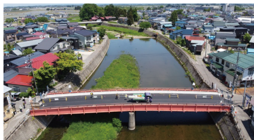
二万石橋 橋梁補修(羽後町西馬音内)
