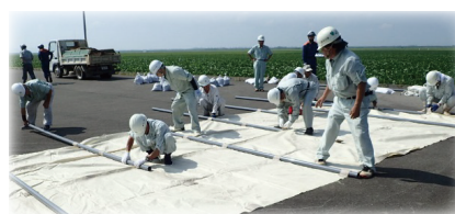
防災訓練でのシート張り実習
