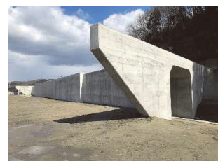
二ツ井地区道路改良工事
