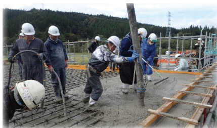
能代市ニツ井町 ボックスカルバート設置工事
