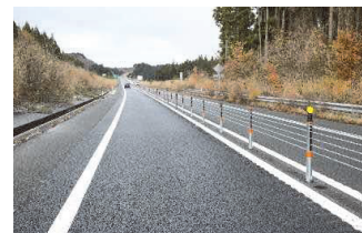
能代管内交通安全対策工事
