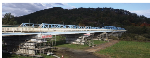
道路メンテナンス(橋梁補修) 琴音橋
