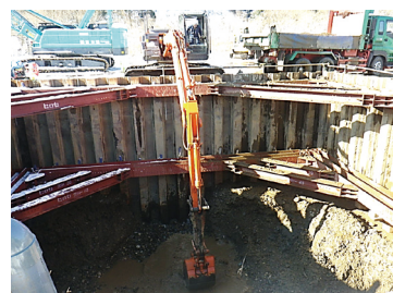
地方道路交付金工事 (改築) 02-HF35-20
