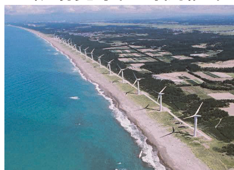
八竜風力発電所建設工事
