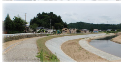
三種川 河川改修工事
