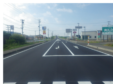
地方道路交付金工事 (舗装補修) 02-FI43-K4
