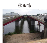
耐震補強工事
