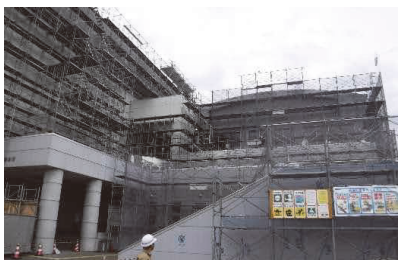
(能代市総合体育館大規模改修)
