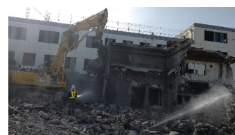
(株)秋田放送旧本社屋解体工事
