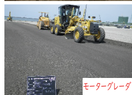
ICT建設機械 による施工
