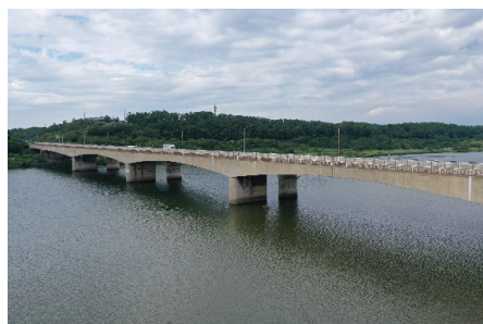
雄物大橋橋梁補修工事
