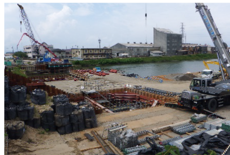
新川橋架替工事
