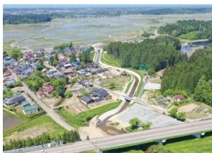
馬踏川改修工事
