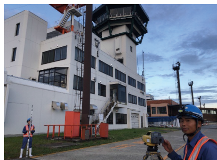
※佐藤心・秋田空港管理棟前で測量中
