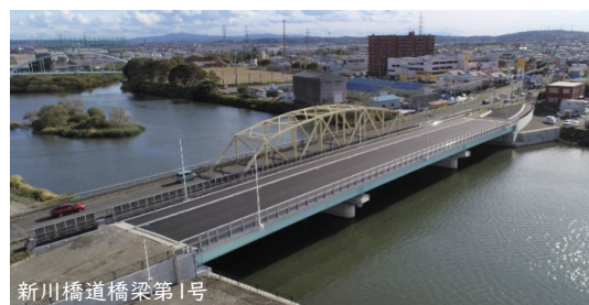
新川橋道橋梁第1号 市道川尻新屋線新川橋架替工事(下部工)令和元年3月完成 市道川尻新屋線新川橋架替工事(床版・橋面工)令和2年11月完成
