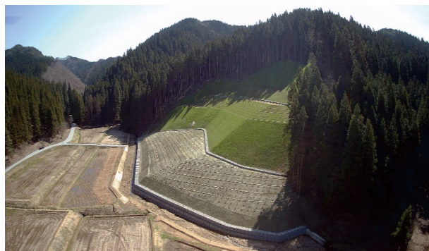
大四郎沢地区復旧治山工事
