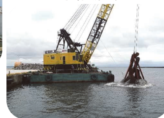
港湾整備工事
