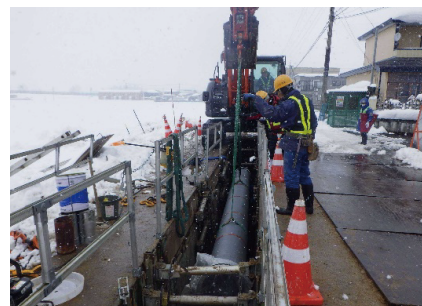
秋田湾・雄物川流域下水道工事 施工中
