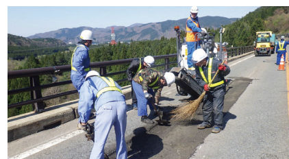
角館国道維持補修工事 作業写真
