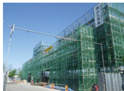
本荘除雪ステーション建築工事
