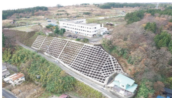
急傾斜地崩壊対策工事(男鹿市船川港女川)
