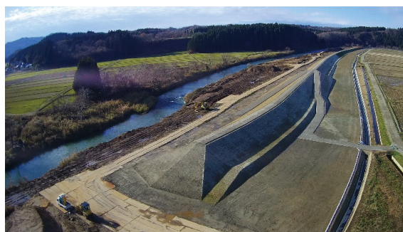
災害対策等緊急工事(大仙市協和下淀川)
