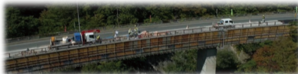
国道46号線(角館～盛岡間) 角館橋梁補修工事
