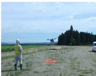
UAVによる起工測量状況
