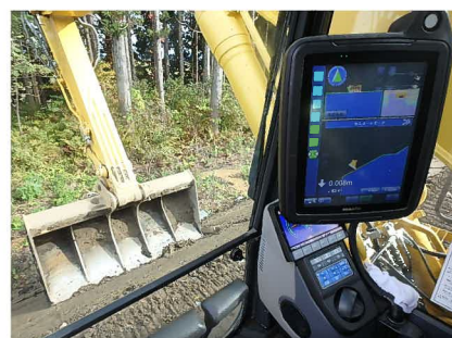
ICT建設機械による施工状況
