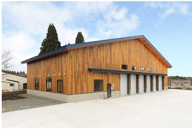
林業研究研修センター 機械実習棟
