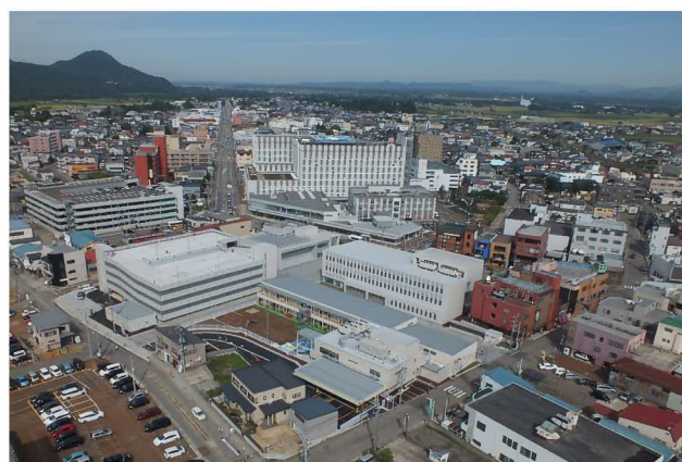
大曲通町地区 (全景)
