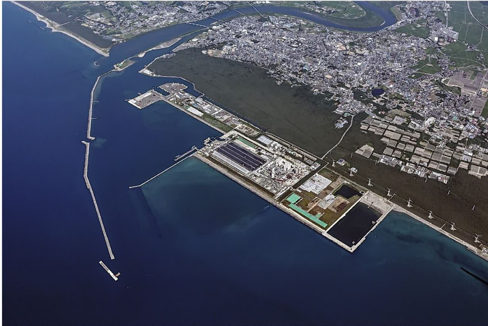
能代港全景(平成30年7月撮影)
