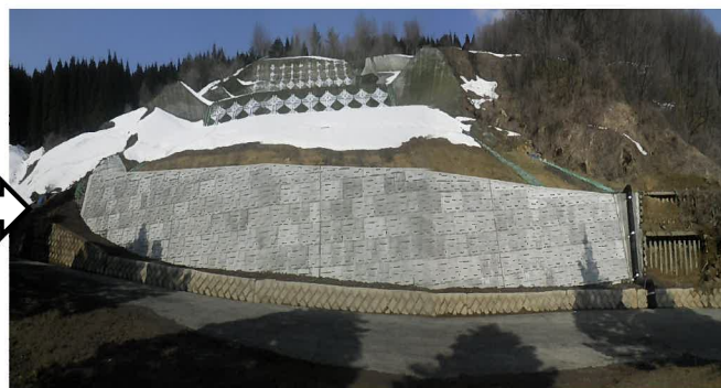
復旧工事完了
