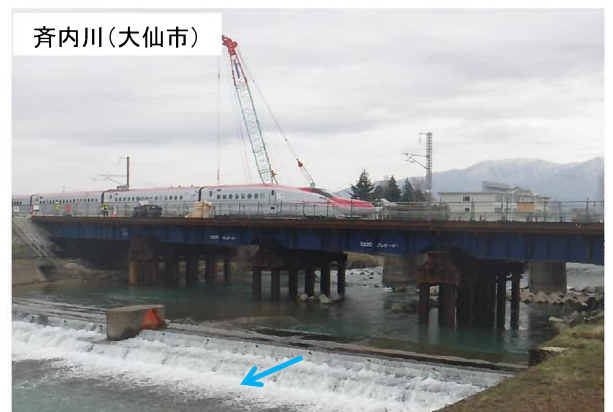
《JR橋の架替工事に着手(架設用栈橋施工状況)》
