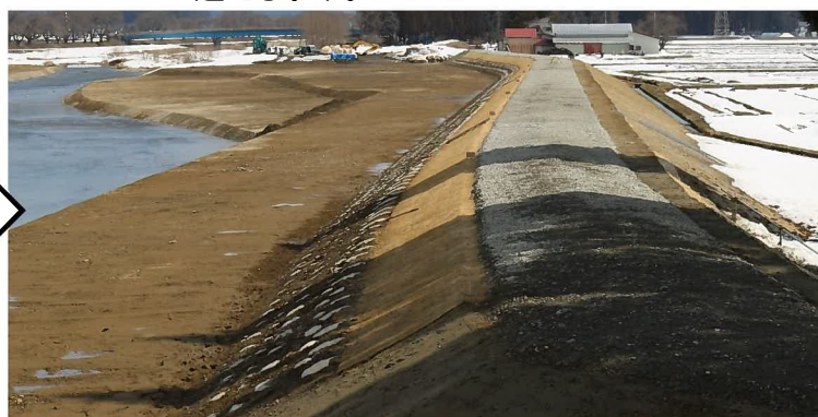
復旧工事完了
