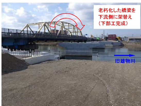
【秋田市】 川尻新屋線（新川橋） 大規模更新事業
