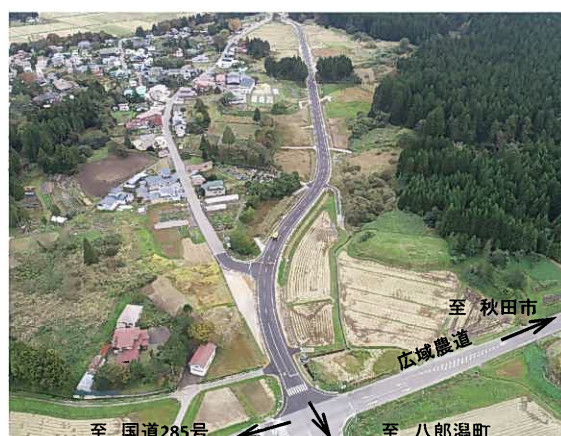
(主) 秋田八郎潟線 五城目町 町村バイパス (平成30年10月26日供用)
