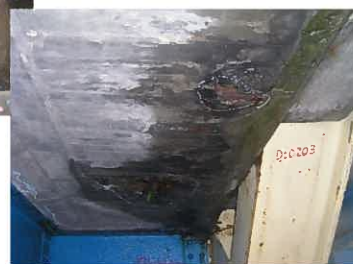
▼鉄筋が露出した床版
