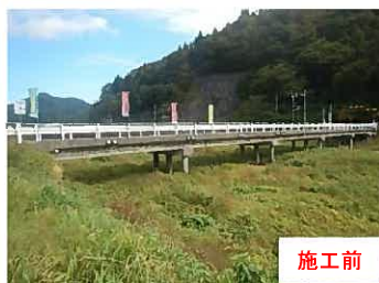
【大館市】 松原1号線（松原橋）橋梁補修
