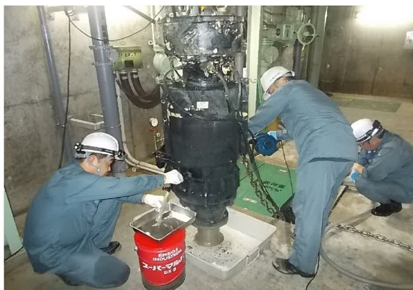
処理施設の点検
