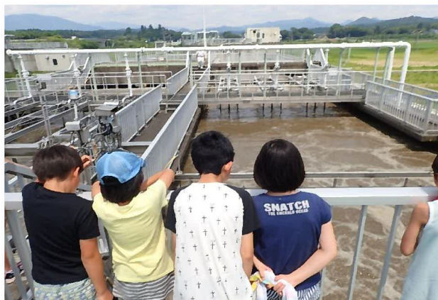
大館処理センター
