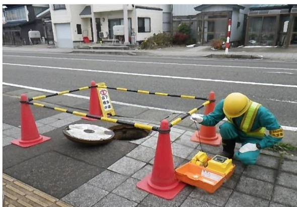
マンホールの点検
