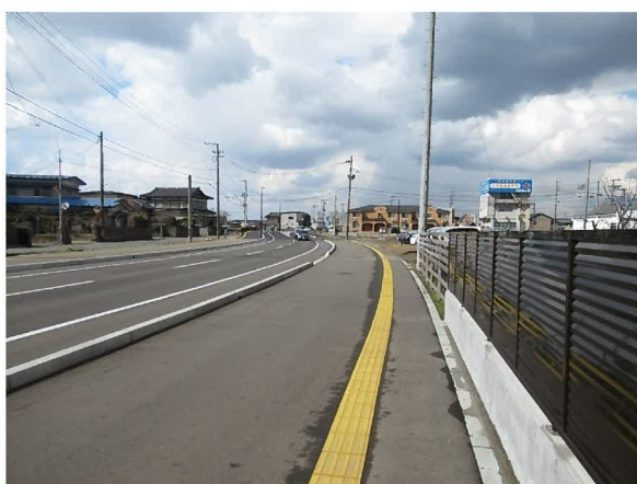
【市事業】 外旭川新川線 秋田市八橋
