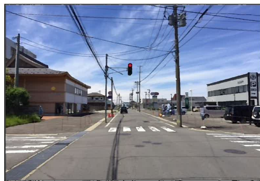
【歩道未設置通学路の安全を確保する街路事業】 3・4・4停車場栄町線 由利本荘市裏尾崎町地内 (用地取得状況)
