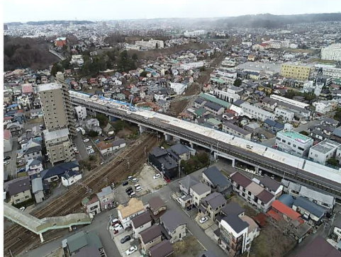
【橋梁の拡幅・耐震補強等による防災性能の向上】 3・4・27千秋広面線 秋田市手形陸橋 (広面側 床版設置完了)
