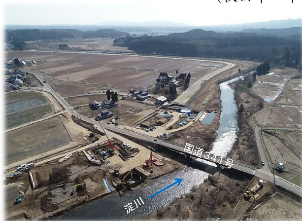
改良復旧工事が進む一級河川 淀川 (大仙市)
