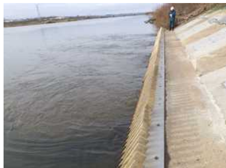
(新) 取水口（雄物川岸部）
