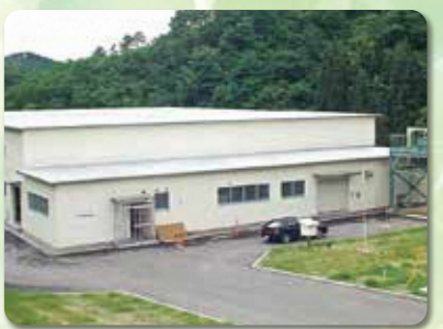
C区浸出水処理施設
