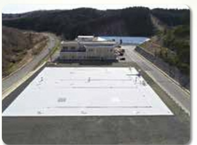
浸出水調整槽②(17,000m³)
