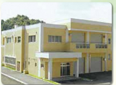
D区浸出水処理施設
