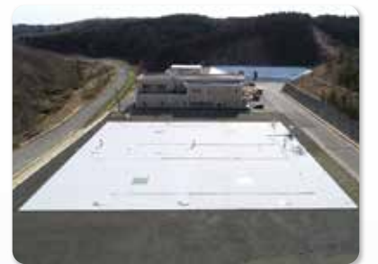
浸出水調整槽(17,000m³)
