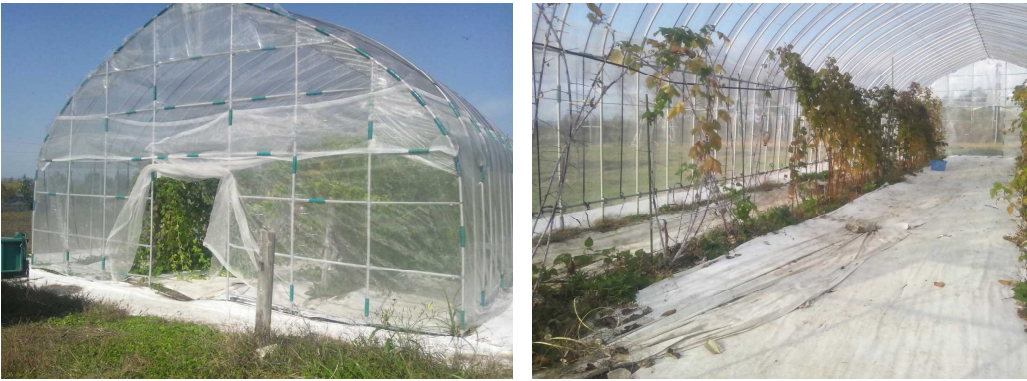
図1 白色反射資材と防虫ネットを設置した雨除けハウス（左：ハウスの外観、右：ハウス内部）
