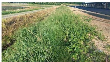
防草マットの設置前
