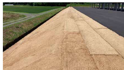
防草マットの設置後
