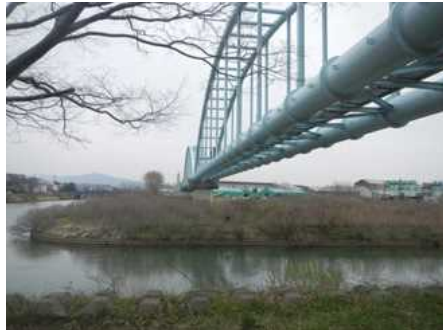
第二送水管（茨島水管橋）
