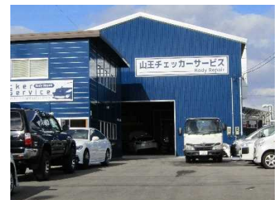
新設した钣金・塗装工場
