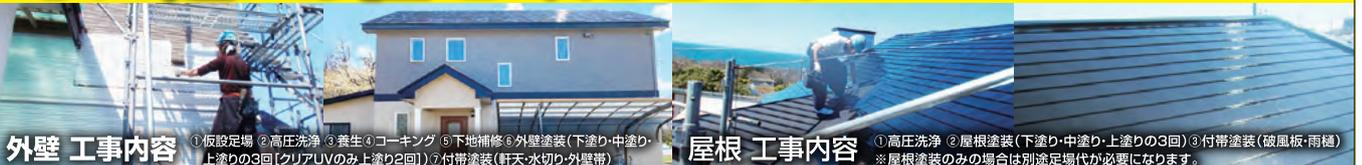
**外壁 工事内容** ①仮設足場 ②高圧洗浄 ③養生 ④コーキング ⑤下地補修 ⑥外壁塗装(下塗り・中塗り・上塗りの3回[クリアUVのみ上塗り2回]) ⑦付帯塗装(軒天・水切り・外壁帯)
