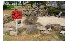
中庭「ザ・池」工事の様子
