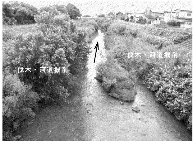
県単河川等環境維持修繕事業 草生津川 (秋田市)
