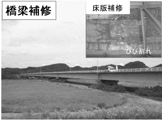
(主) 四ツ屋神岡線 松倉橋 (大仙市)
