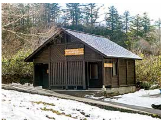
後生掛温泉公衆トイレ
