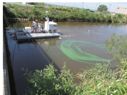
アオコ抑制装置による悪臭被害防止対策 馬踏川（潟上市）
