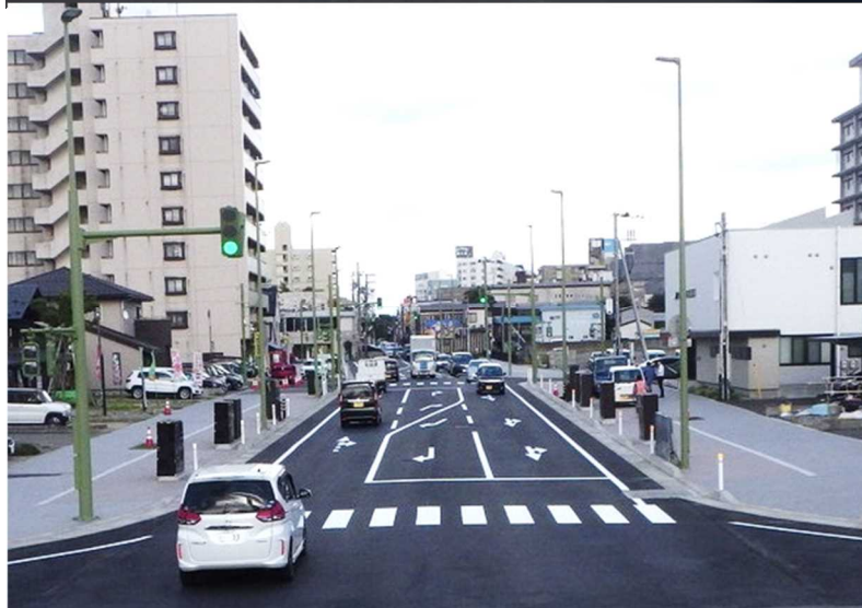
川尻広面線〔横町工区〕 令和5年8月
