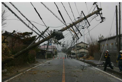
【緊急輸送道路の通行を妨げる電柱】
