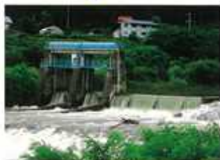
一の渡頭首工
