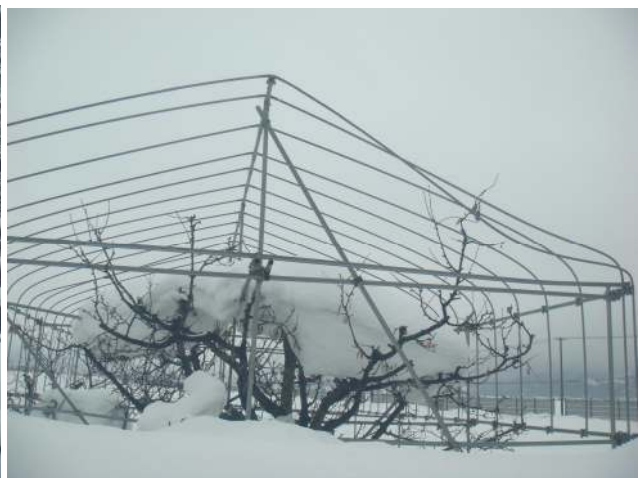
図51 枝が多く冠雪が大きくなった状態
