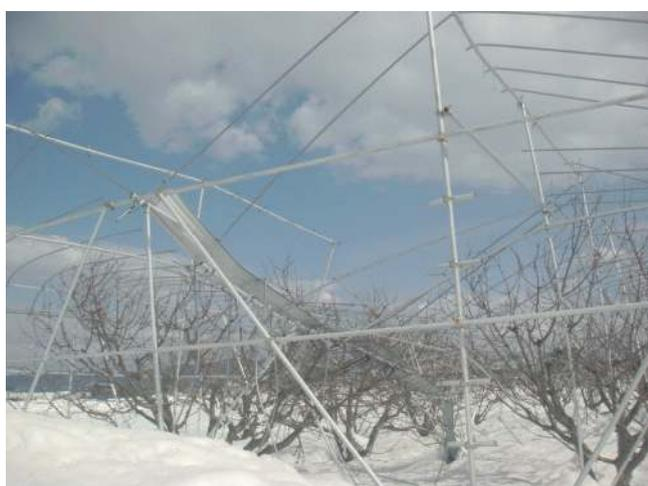
図7 冠雪で倒壊した雨よけ施設
