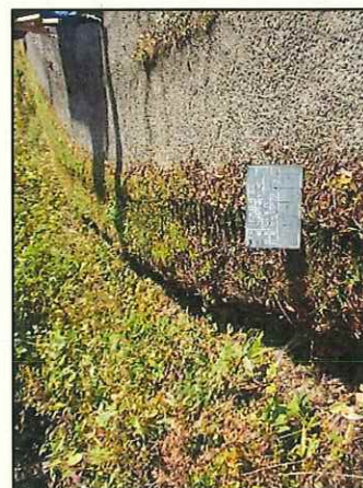
【施工前の水路状況】
