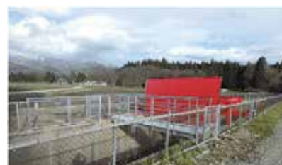
大野中水位調節ゲート（施工後）
