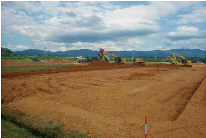
客土整備 鹿角第二地区（鹿角市）
