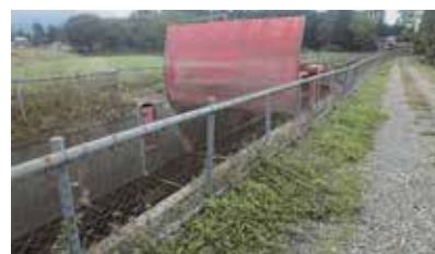
大野中水位調節ゲート（施工前）
