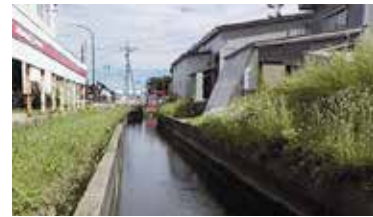
旭川左岸幹線用水路（施工前）
