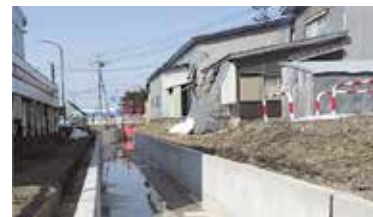
旭川左岸幹線用水路（施工後）
