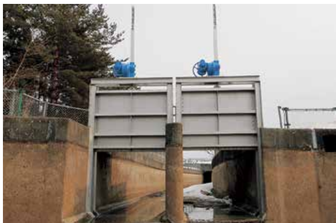
ゲートの更新 能代1期地区（能代市）
