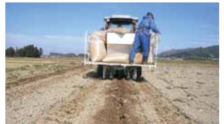
モミガラ補助暗渠の施工状況 （湯沢市）
