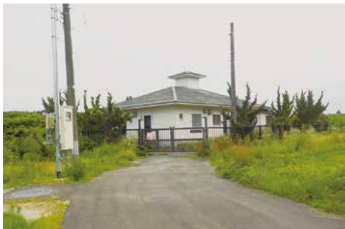
農業集落排水処理施設の整備 飛沢地区（秋田市）
