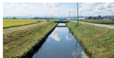
着工前（大宮川幹線排水路）
