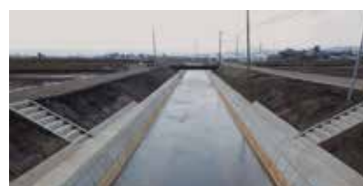
着工後（大宮川幹線排水路）
