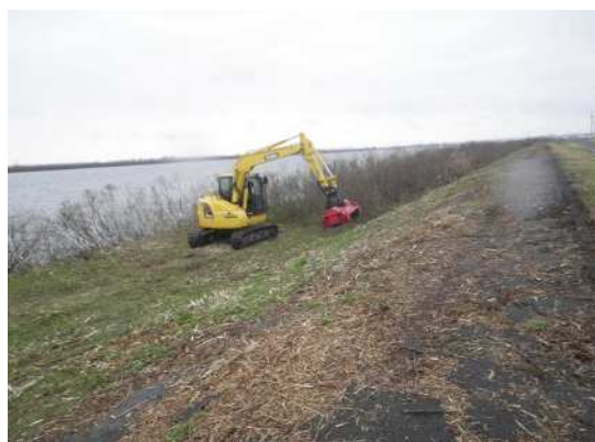
湖岸(東部承水路 H30.10) ※河川維持作業(業者委託)
