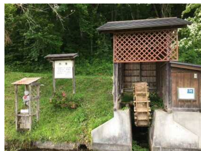
小水力発電施設
