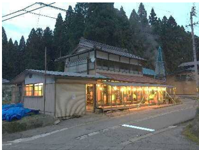
交流拠点の整備(古民家改修)
