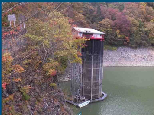
素波里 取水塔
