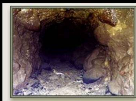
穴山用水堰(水土の礎より)
