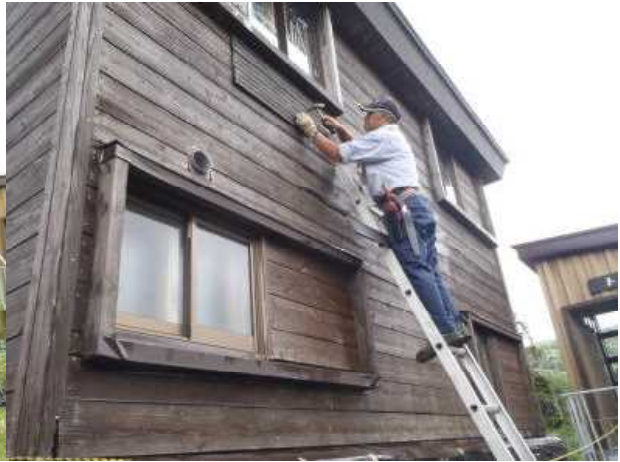
(↑外壁の補修作業の様子)
