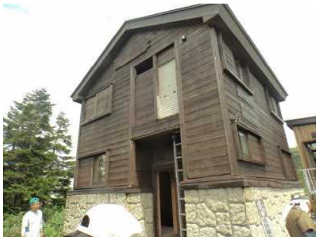
(↑塗装後の避難小屋)
