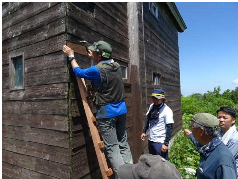
(↑ はがれかけた外壁の補修)
