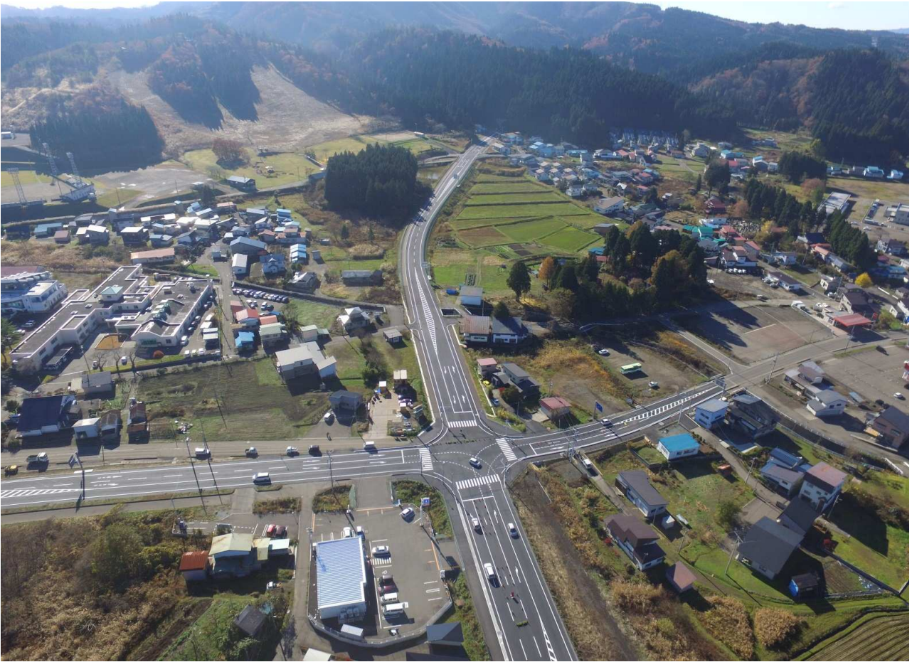
国道285号 滝ノ沢バイパス（H30. 11月全線開通）
