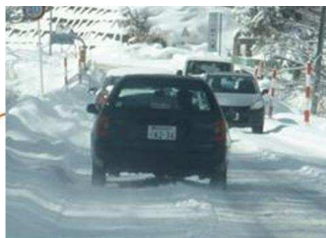
◆雪沢地区の冬期現道状況
