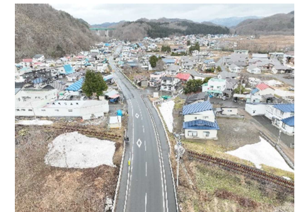
現道拡幅・歩道整備工事の状況
