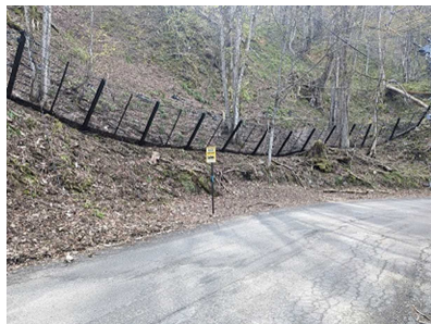
自然災害(落石)対策
