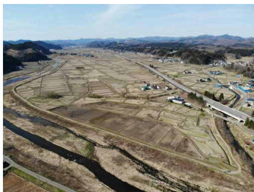
【毛馬内北部地区（工事実施前）】
