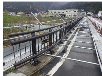
橋梁防護柵の更新
