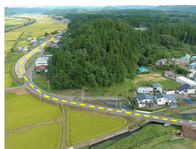
工事が進む線形改良区間
