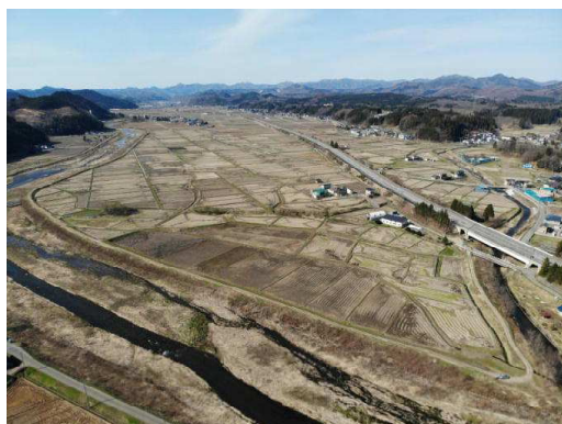
【毛馬内北部地区（工事实施前）】
