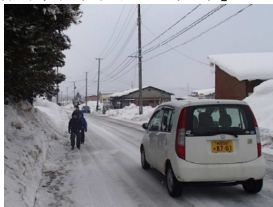
冬は堆雪で道幅が狭くなり危険
