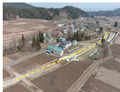
工事が進むバイパス区間
