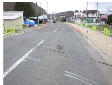
現道拡幅工事の状況
