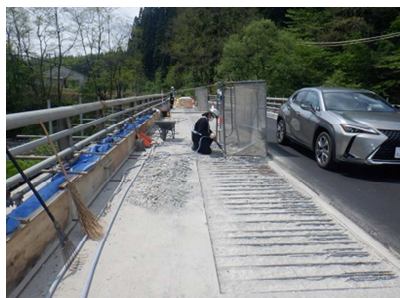
橋梁床板の補修
