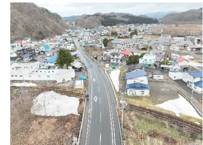
現道拡幅・歩道整備工事の状況
