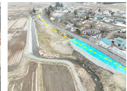
工事が進む現道拡幅区間
