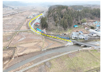
工事が進む線形改良区間
