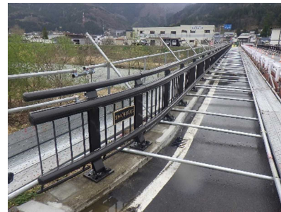
橋梁防護柵の更新
