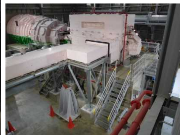
これがタービン(左)と発電機(右)。蒸気によりタービンを回し、発電させる。
