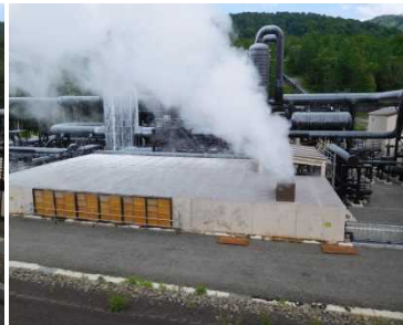
蒸気を取り出した後の熱水は、熱水ピットに集められ、還元基地へ。
