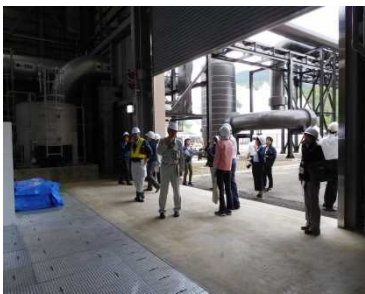
発電所本館(タービン棟)へ。 .....
