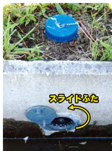
上流側の注水口
