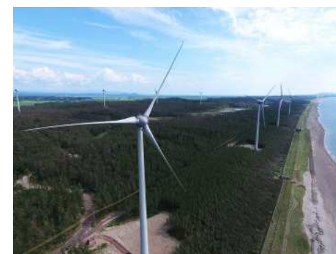
風の松原風力発電所(能代市)
