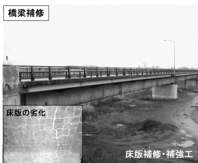
国道105号 大曲大橋 （大仙市）
