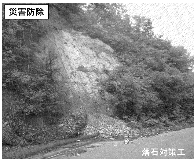
（一）西目屋二ツ井線 藤琴沢国有林工区 （藤里町）
