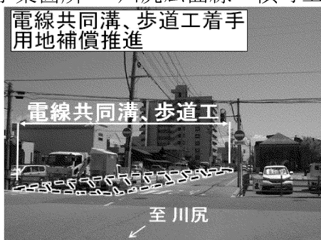
川尻広面線 横町工区 (秋田市)
