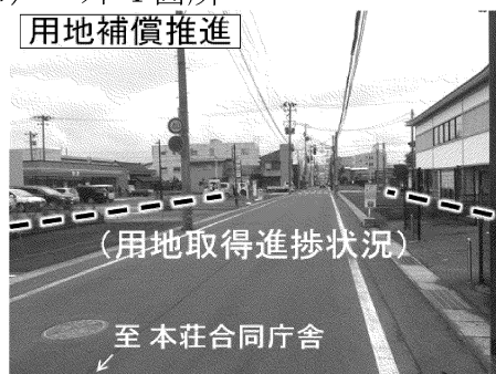
停車場栄町線 裏尾崎町工区 (由利本荘市)
